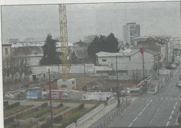
TAILLE XXL. La future extension, dont la construction va débuter, offrira 2.000 m 2 pour le campus universitaire. G.B.
